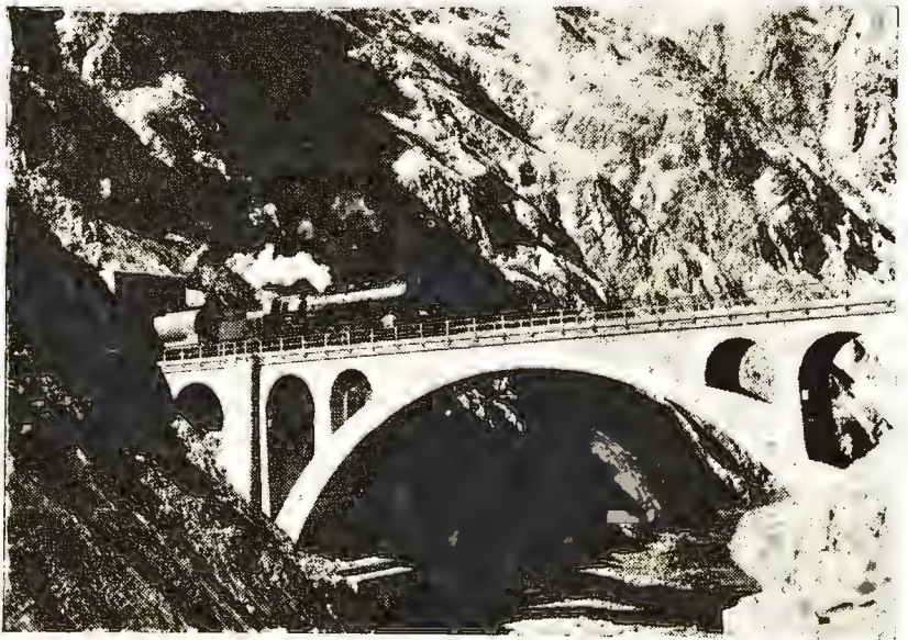
پل جنب راه آهن ایستگاه کشور در خط جنوب
